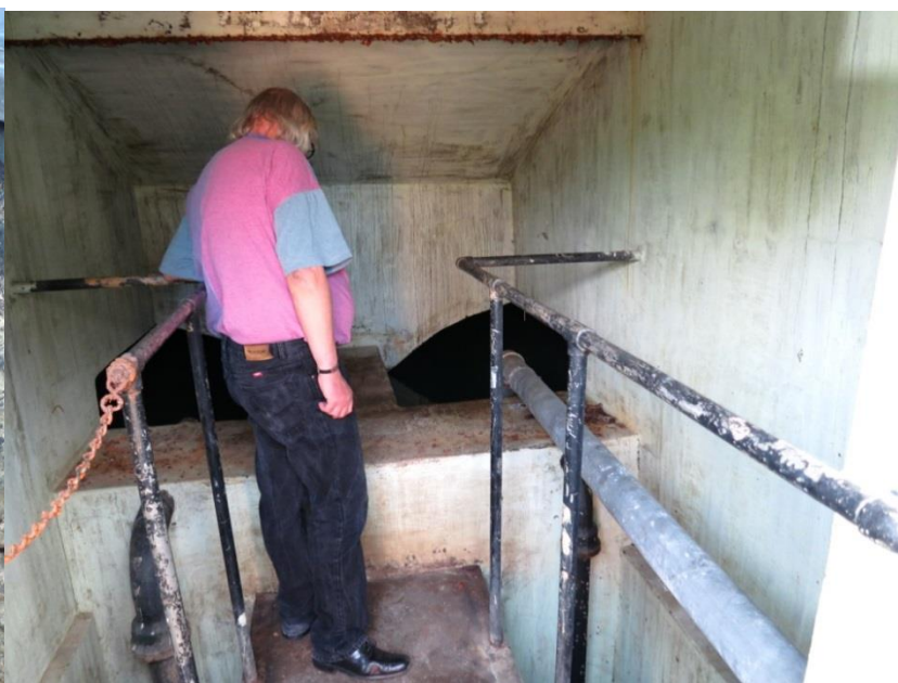
Blick ins alte Wasserreservoir von 1908
