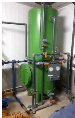
1. durch einen Kiesfilter, gefüllt mit Semidol – einem dolomitischen Filtermaterial, gewonnen aus reinem Dolomit – unter Zugabe von Luftsauerstoff. Dies dient zur Entsäuerung des Wassers und entzieht im Rohwasser enthaltenes Eisen und Mangan.
